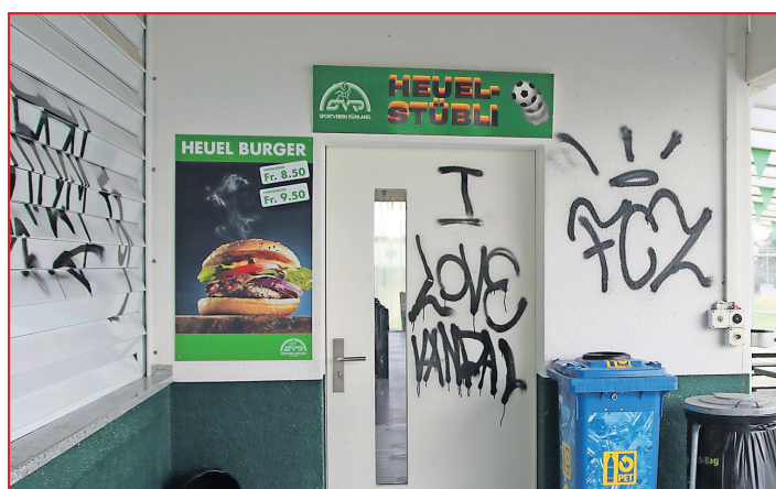
Auch der Eingang zum Clubhaus des SV Rümlang wurde stark verschmutzt mit Tags und Schriftzügen.
